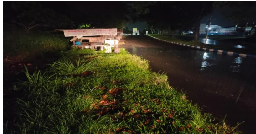
Gambar 1.1 Situasi Lokasi Jalan Bakti Husada Saat Hujan Tahun 2020
