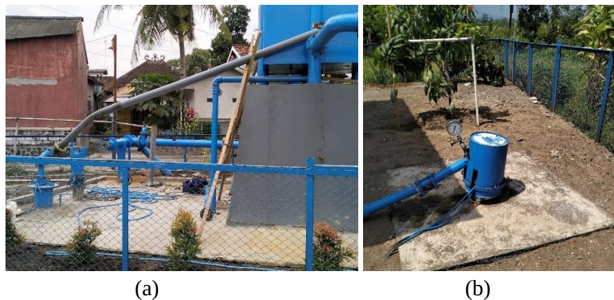
Gambar 4. 1 (a) Sumber Air Baku Utama (deep well) dengan Kedalaman Galian sekitar 40 meter, (b) Sumber Air Baku (Sumur Bor) 2 dengan Kedalaman Galian sekitar 20 meter
