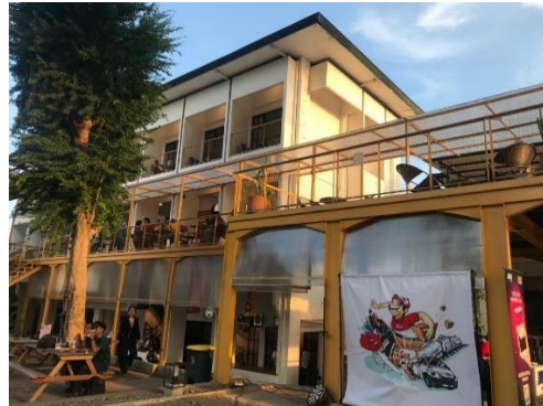
Gambar 9 Paviliun JNM Bloc Sumber: Dokumentasi Penulis, 2023
