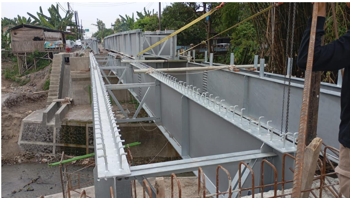
Gambar A 2 Proses Pemasangan Besi H-Beam
