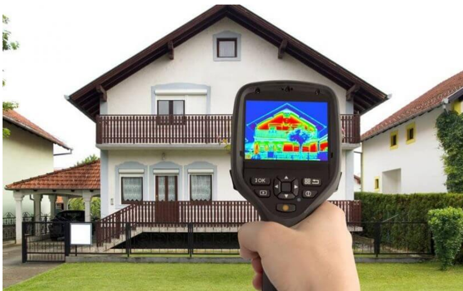
Gambar 3.8 Thermal Imaging pada Sebuah Bangunan
