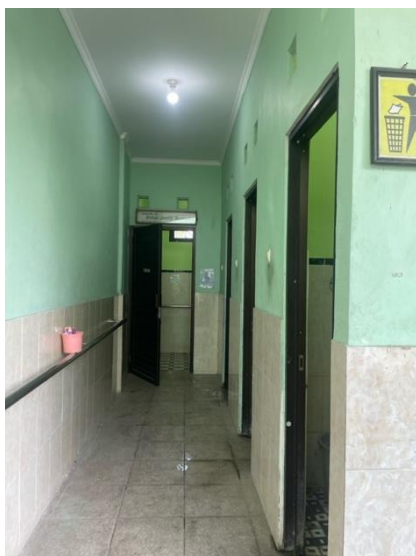
Dokumentasi fasilitas toilet sekolah
