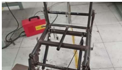
Gambar 4-24 Foto gas spring yang sudah terpasang.
