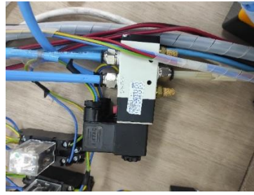
Gambar 4-24 Pemasangan selang PU dan relay
