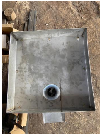
Gambar 3.12 Proses Pemasangan Hopper
