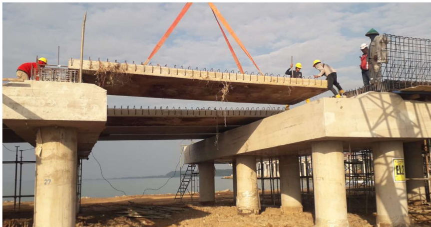
Gambar 5.31 Proses Pemasangan Half Slab (sumber: proyek pembangunan infrastruktur akses jalan jetty kit batang)
