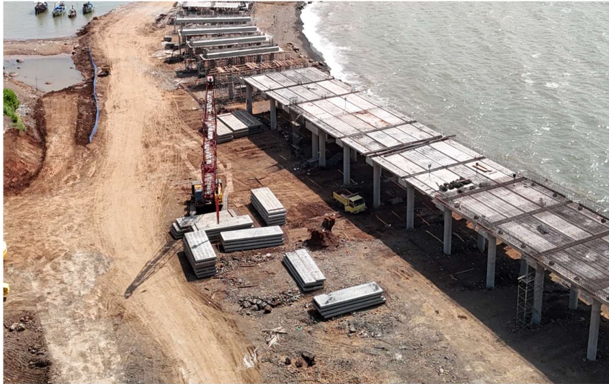
Gambar 5.30 Proses Angkat Half Slab Dari Stock Yard Terdekat (sumber: penulis 4/6/2024)
