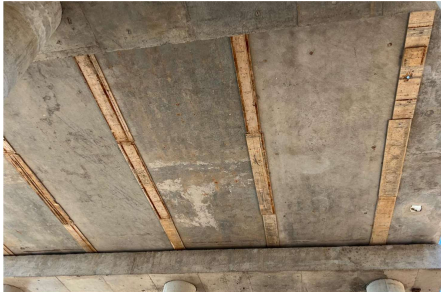
Gambar 5.33 Bekisting Gantung Yang Telah Terpasang (sumber: penulis 15/6/2024)
