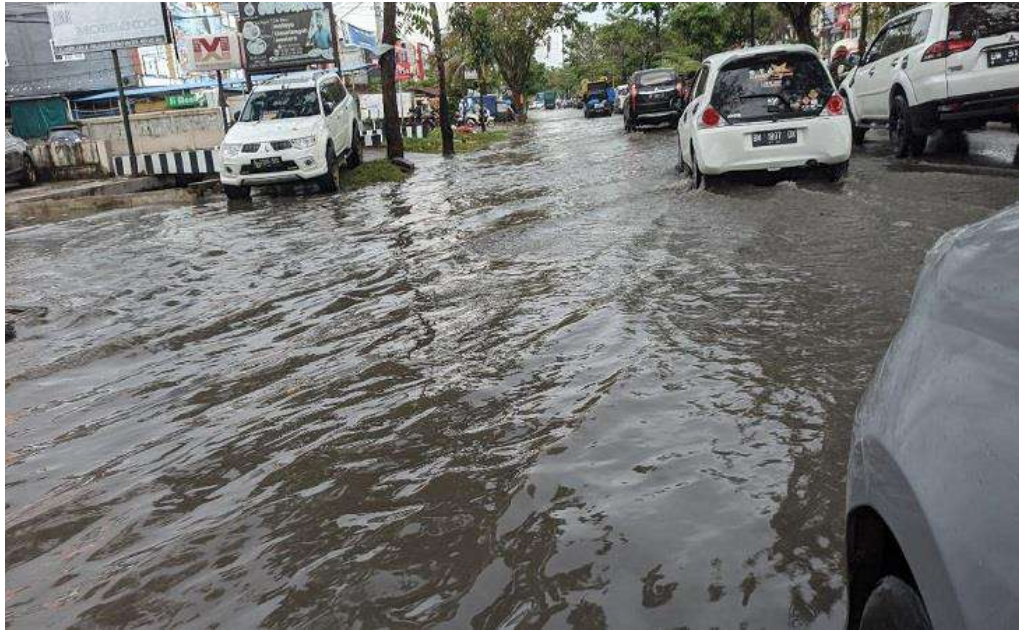
Gambar 1.1 Banjir Karena Selokan Lebih Tinggi dari Jalan di Pekanbaru
