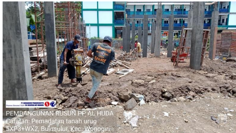
Gambar 5. 2 Tingkat Kepatuhan Penggunaan APD Lokasi Kab. Wonogiri Sumber: Data Lapangan (2022)
