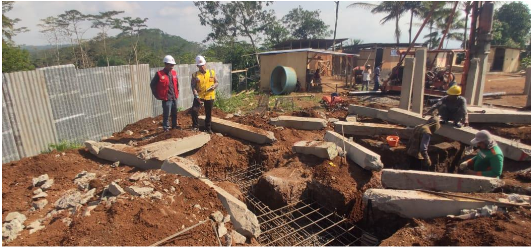
Gambar 5. 6 Proses Pengawasan dan Pengendalian Lokasi Pembangunan
