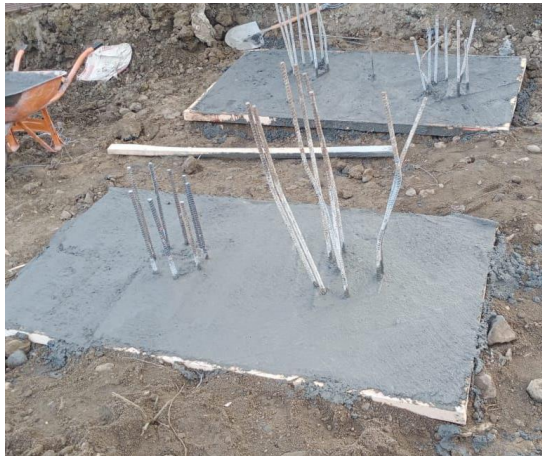
Gambar L-2. 5 Pengecoran Pondasi Bore Pile Selesai
