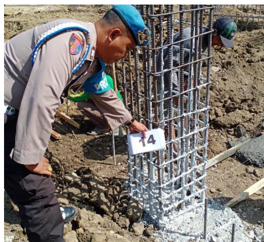
Gambar L-2. 6 Pengecekan struktur pondasi dan kolom
