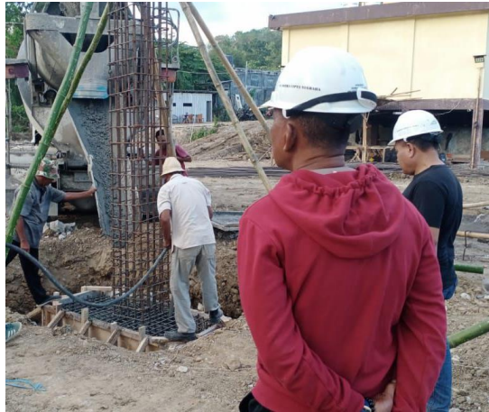
Gambar L-2. 4 Pengecoran ( Pekerja Tidak Menggunakan APD Lengkap)
