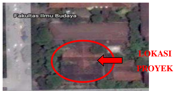
Gambar 4.1 Lokasi Penelitian Pembangunan Gedung R.Soegondo Fakultas Ilmu Budaya Universitas Gadjah Mada
