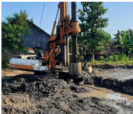
Gambar 5.1 Tanah Berlumpur Saat Pengerjaan Bore Pile
