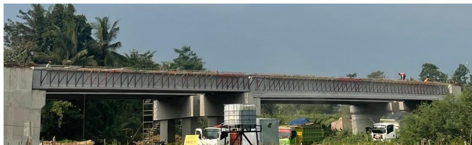
Gambar 1.1 Tampak Samping Pembangunan Jembatan
