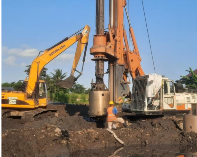
Gambar pengerjaan bore pile pada STA 0+625
