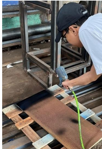
Gambar 3-13 Proses pengecatan penutup rangka
