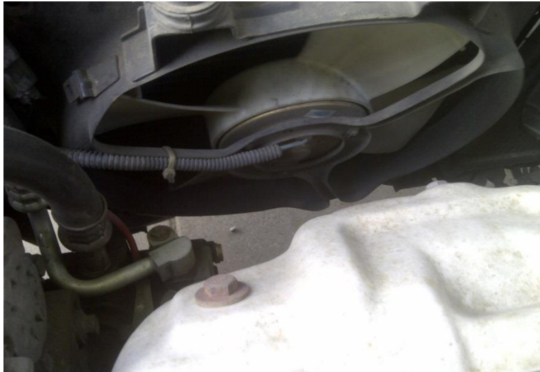
Lampiran A.5. Fan Air Conditioner (kompresor)
