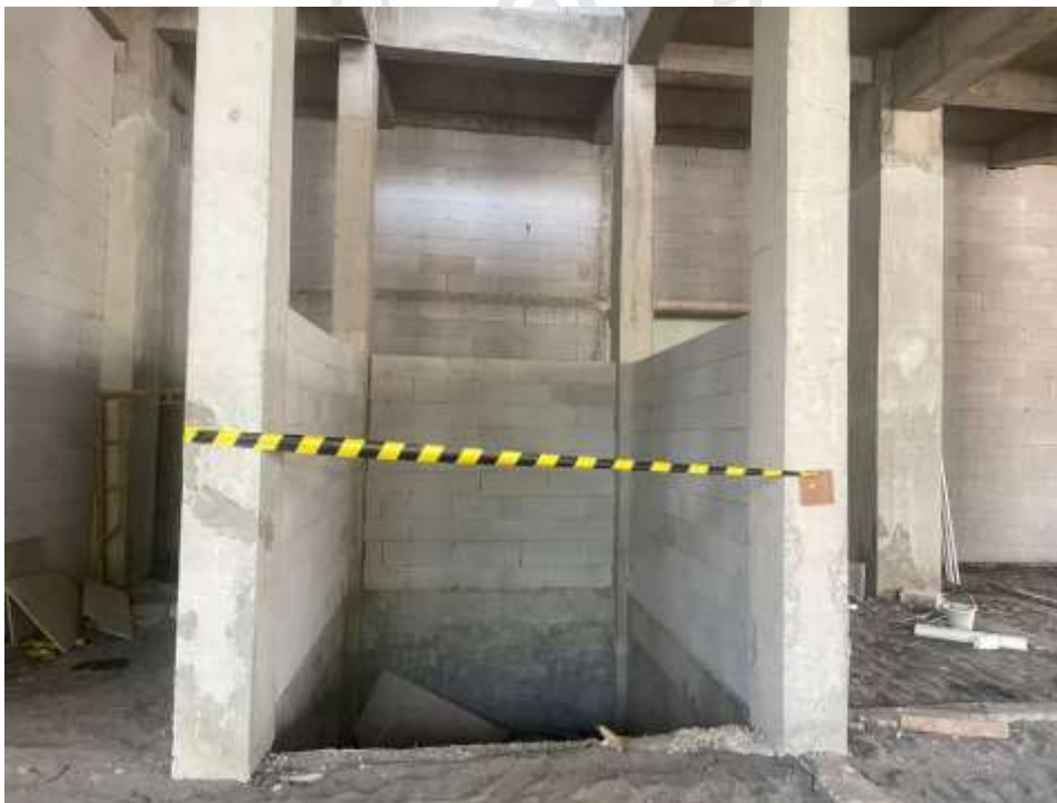
Gambar 5.5 Label Bahaya di Sekitar Proyek
