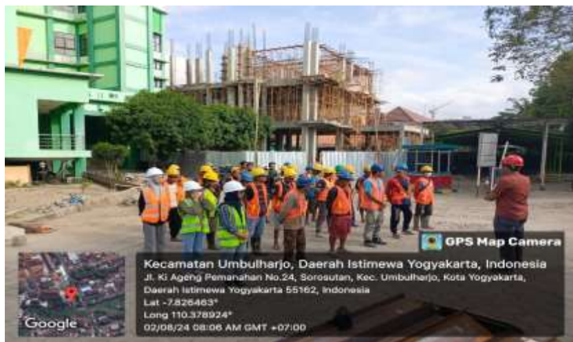
Gambar 5.1. Safety Morning dan Induction Sumber: Dokumentasi Peneliti, 2024
