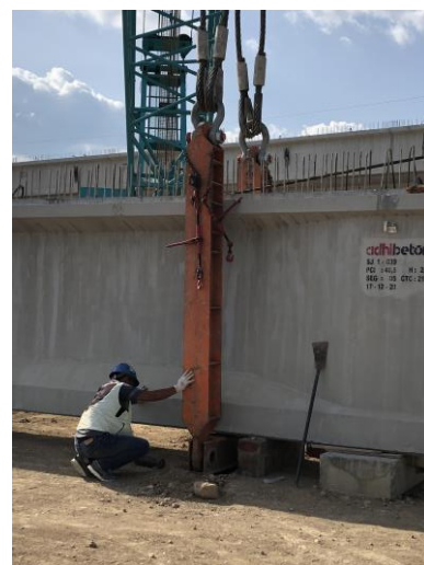
Gambar 5. 10 Erection balok girder menggunakan spreader beam pada gambar sebelah kiri dan menggunakan lifting frame pada gambar sebelah kanan
