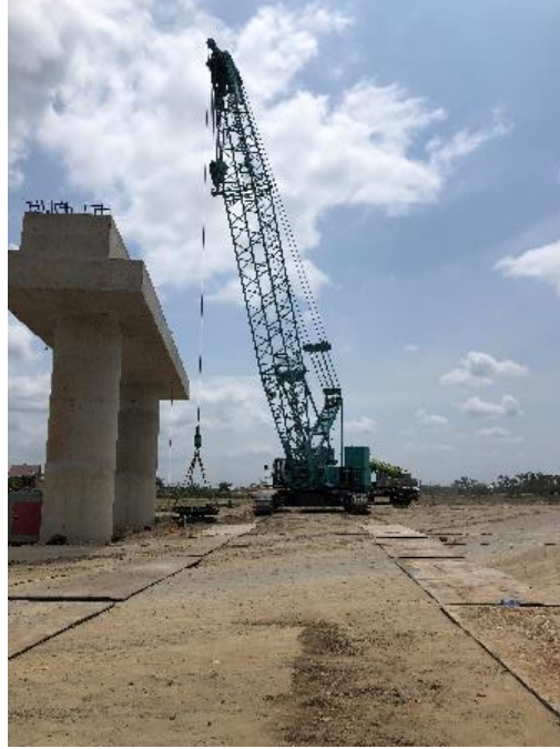
Gambar 5. 8 peletakan pelat baja pada jalur crawler crane sebagai salah satu bentuk safety pekerjaan erection yang dilakukan oleh PT CASH sebagai subkontraktor erection PCI girder (sumber: Dokumentasi Pribadi)
