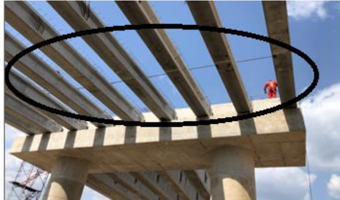
Gambar 5. 11 Breasing yang dilakukan pada bentang 16,6 meter (Sumber: Dokumentasi pribadi)
