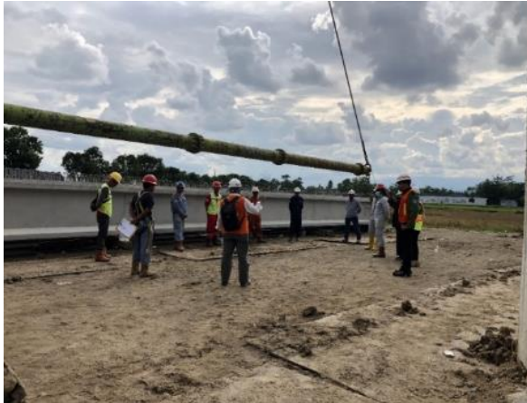
Pelaksanaan Pekerjaan Stressing
