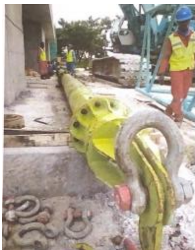
Gambar 5. 10 Erection balok girder menggunakan spreader beam pada gambar sebelah kiri dan menggunakan lifting frame pada gambar sebelah kanan
