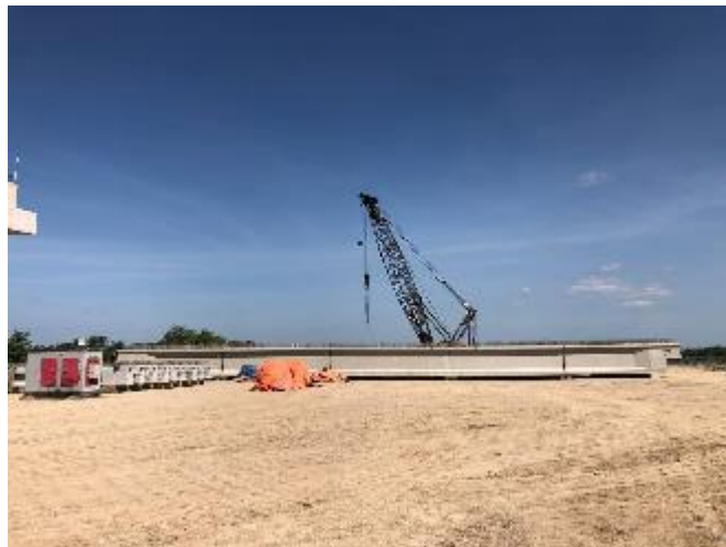
Gambar 5. 6 Area peletakan segmen-segmen balok girder (sumber: Dokumentasi pribadi)
