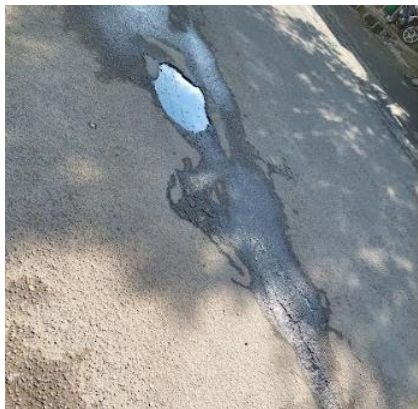
Gambar 5. 9 Contoh Kerusakan Pothole di Jalan Suprpto Barat yang Diakibatkan Parahnya Kerusakan Alligator Cracking
