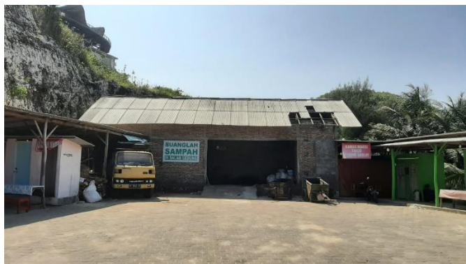
Gambar 4.7 Tempat Penampungan Sementara Pantai Drini
