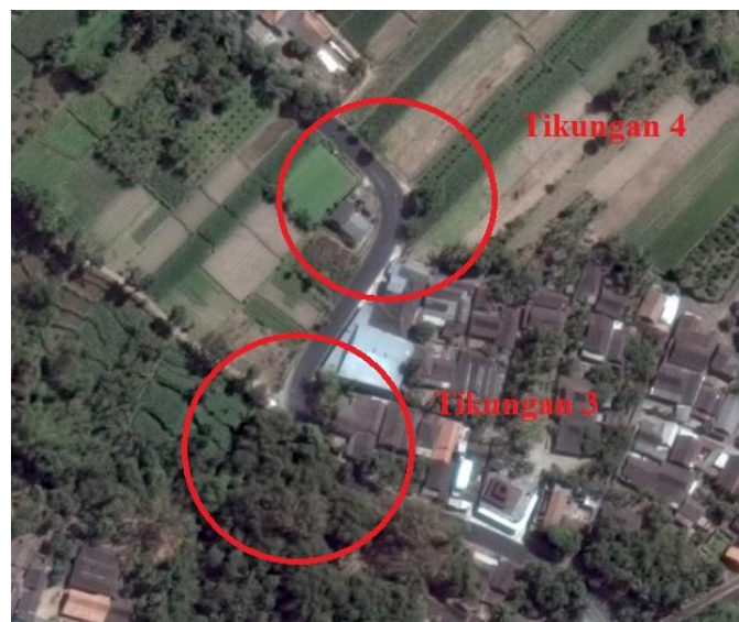
Gambar 1.10 Tikungan 3 dan 4 Jalan Klaten-Jatinom, Klaten, Jawa Tengah
