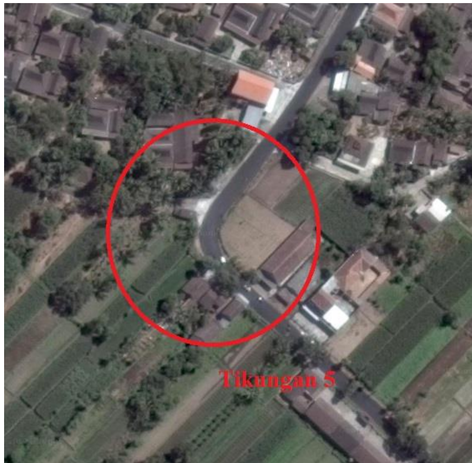
Gambar 1.11 Tikungan 5 Jalan Klaten-Jatinom, Klaten, Jawa Tengah
