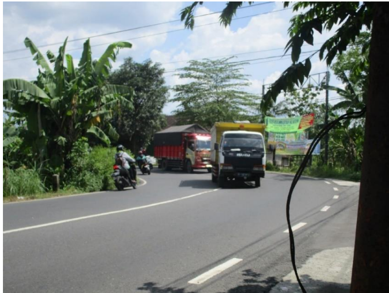
Gambar 1.6 Tikungan 5 Jalan Klaten-Jatinom
