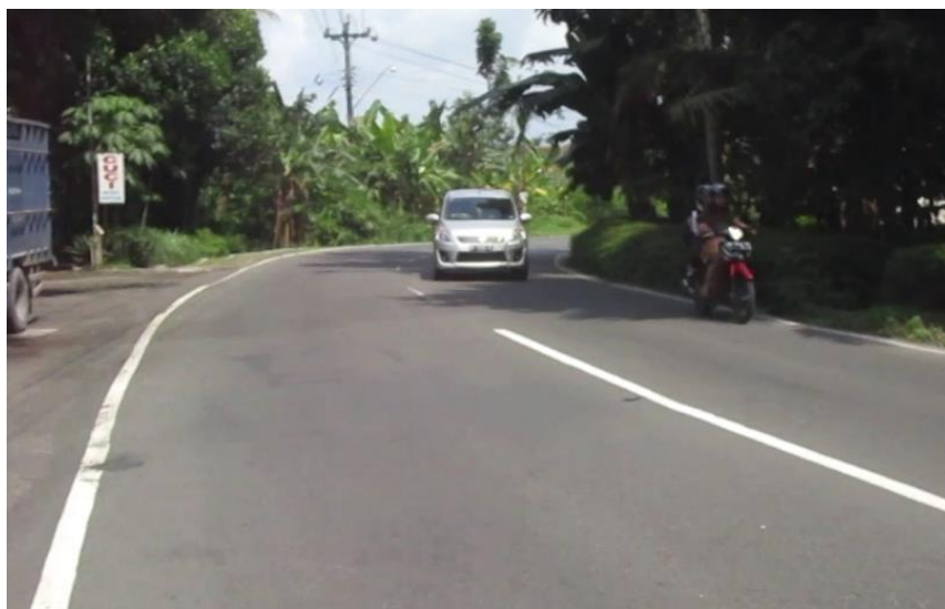
Gambar 1.3 Tikungan 2 Jalan Klaten-Jatinom
