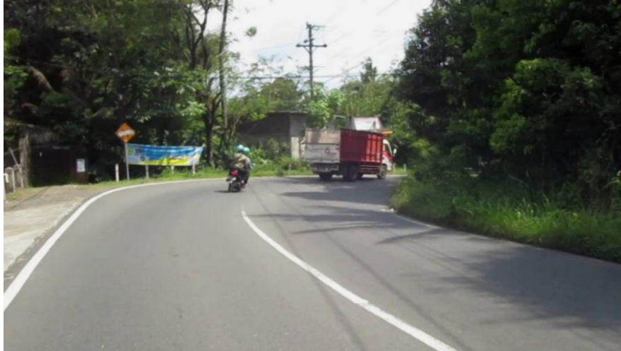
Gambar 1.2 Tikungan 1 Jalan Klaten-Jatinom
