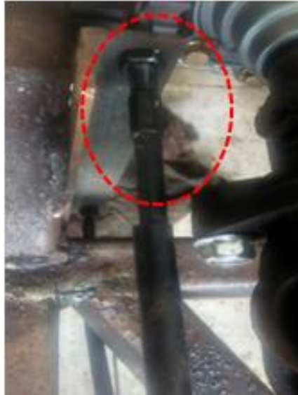
Gambar 4.7 Plat Yang Telah Dilas
