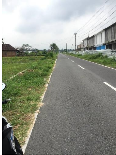
Gambar 4.6 Pengujian pada permukaan jalan yang rata
