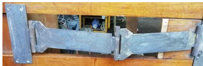
Gambar 4- 56 Engsel yang sudah dilakukan proses pengelasan dengan plat besi
