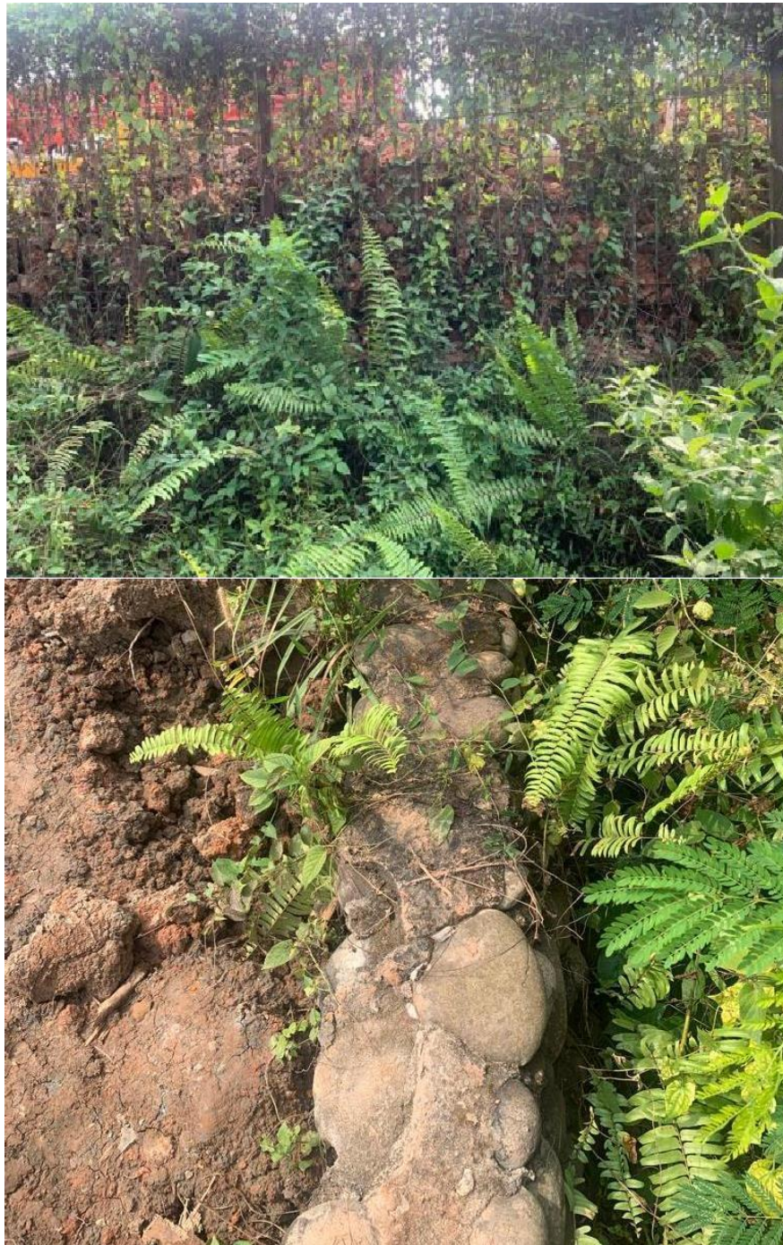
Gambar 4.3 Kondisi lapangan tanah urugan dengan turap eksisting
