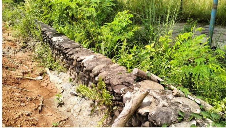
Gambar 5.4 Gambar Turap Eksisting 1 (Sumber : Dokumen Lapangan)
