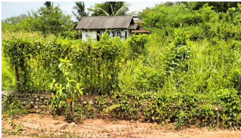
Gambar 5.5 Gambar Turap Eksisting 2 (Sumber : Dokumen Lapangan)
