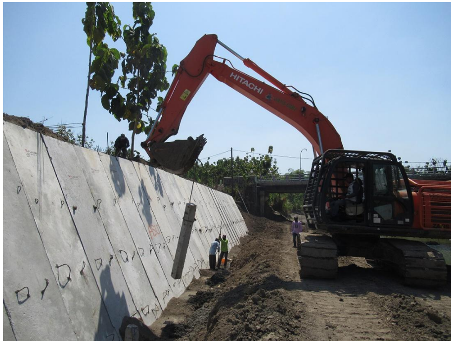
Gambar 5. 25 Pemancangan mini pile \Delta 12 x 12 x 12
