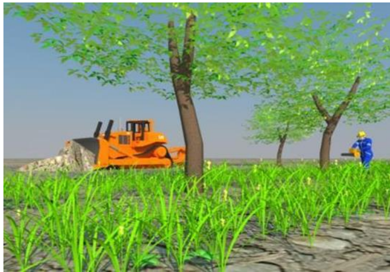
Gambar 5. 23 Ilustrasi Pekerjaan Persiapan Stock Yard
