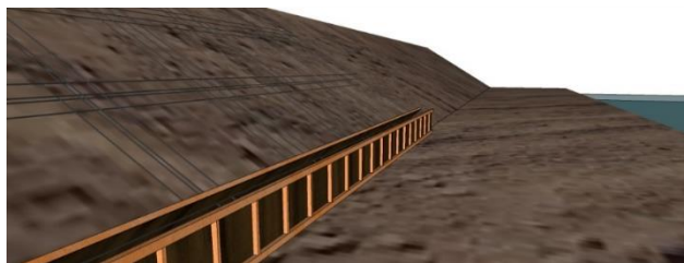
Gambar 5. 7 Ilustrasi Pekerjaan Bekisting Pondasi Bawah
