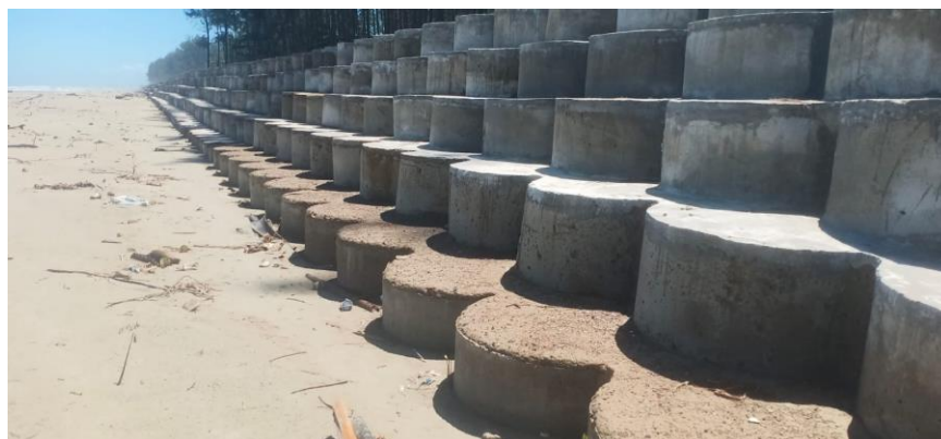
Gambar 3.11 Revetment Tumpukan Buis Beton
