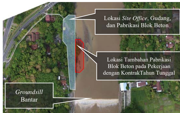
Gambar 5-2 Lokasi Site Office , Gudang, dan Pabrikasi Blok Beton
