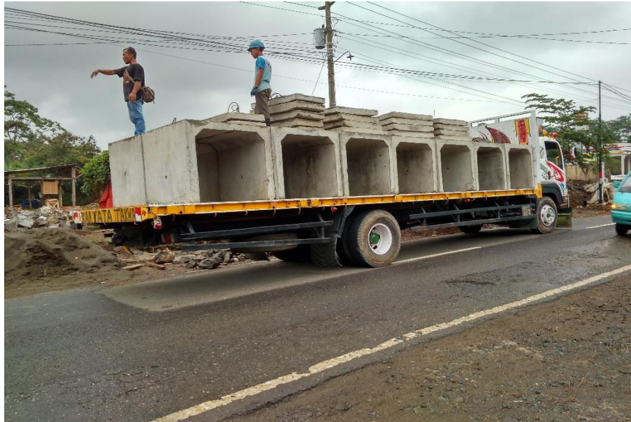
Gambar 5.7 Pengiriman U-Ditch ke lokasi proyek (sumber : Dokumentasi Proyek Trotoar Tambakan Banjarnegara)
