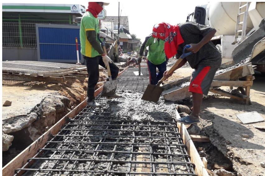
Gambar 5.12 Pekerjaan Saluran Drainase Beton Bertulang Metode Ready Mix (sumber : Dokumentasi Proyek Drainase Jalan Dipayuda Banjarnegara)
