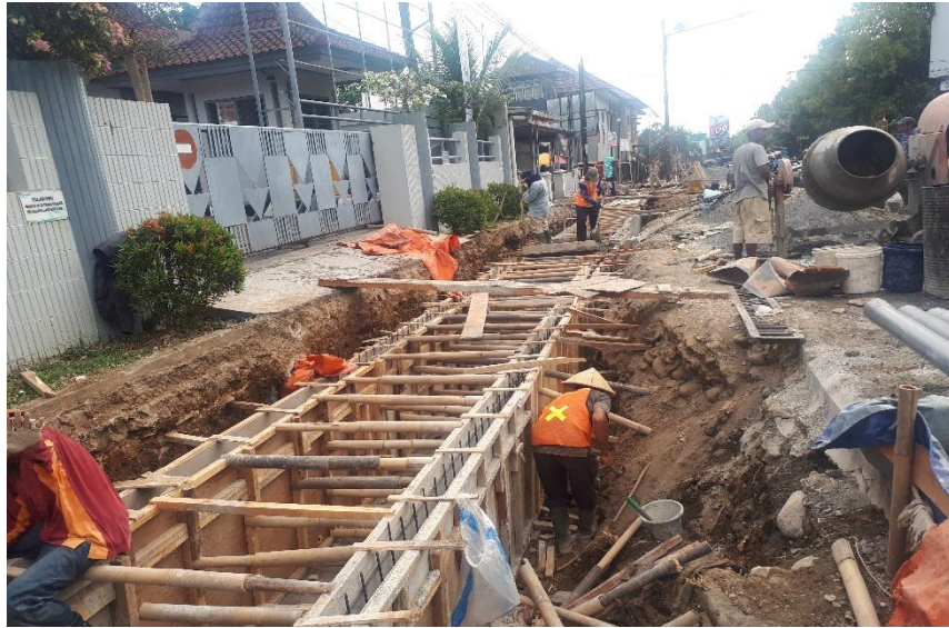
Gambar 5.11 Pekerjaan Saluran Drainase Beton Bertulang Metode Site Mix (sumber : Dokumentasi Proyek Drainase Jalan Pemuda Banjarnegara)
