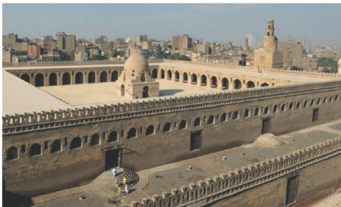
Gambar 24 Masjid Ibnu Thulun dengan ukuran 138 x 118 meter. Ini merupakan masjid tertua di Mesir, dan tempat adzannya sama seperti model Menara di Samara 181
