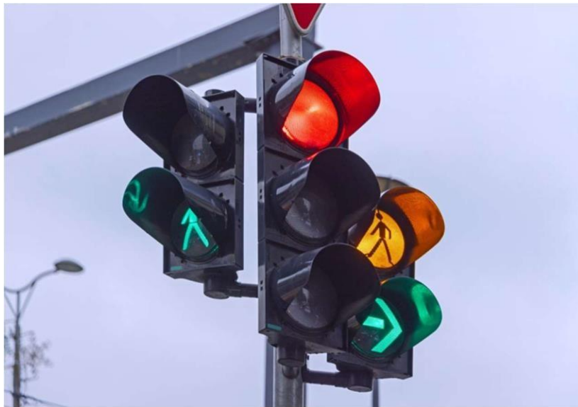
Gambar 1. 1 Bentuk fisik lampu lalu lintas melibatkan sejumlah komponen, termasuk lampu khusus untuk kendaraan dan pejalankaki, serta lampu berbentuk panah
