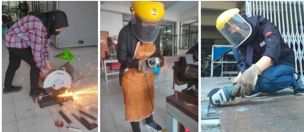
Gambar 4.11 Proses pemotongan besi siku dan plat besi
