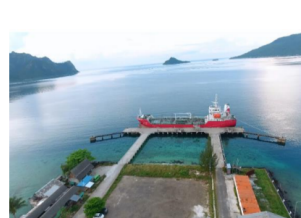
Gambar 1.21 Kondisi Sekitar Lokasi Perencanaan Bagian Selatan Sumber : (Tim Penyusunan Studi RIP dan DLKr & DLKp) Pelabuhan Selat Lampa, Tahun 2017)
