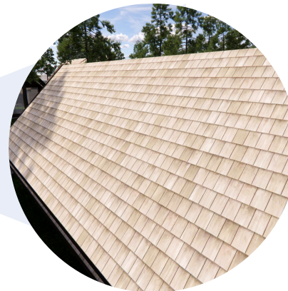
Material atap menggunakan atap sirap
