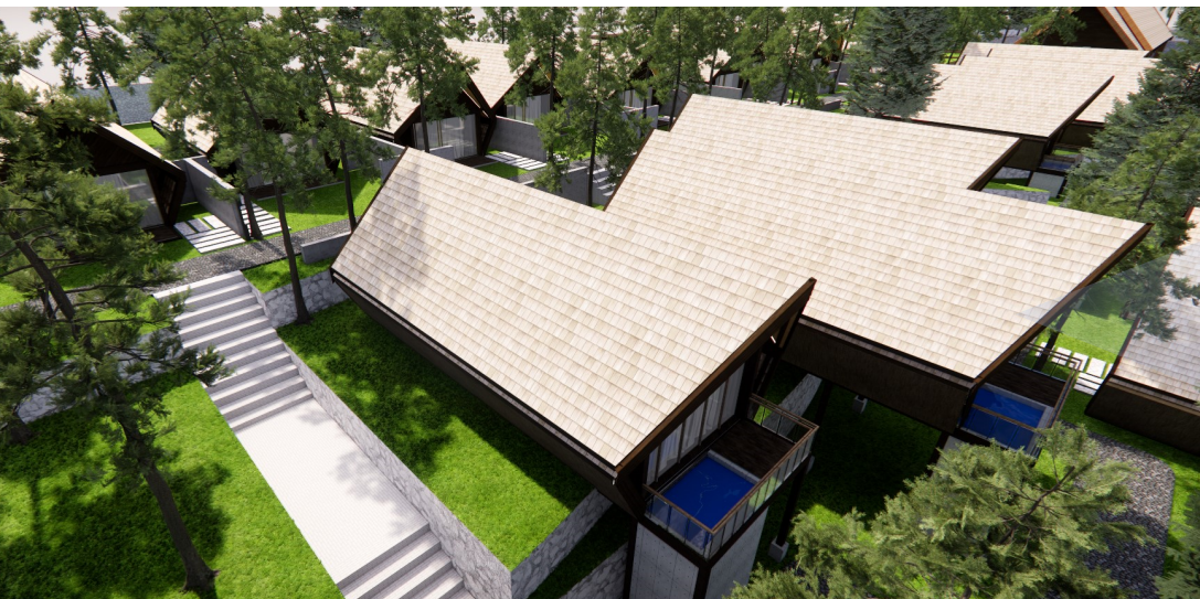
Material atap menggunakan atap sirap
