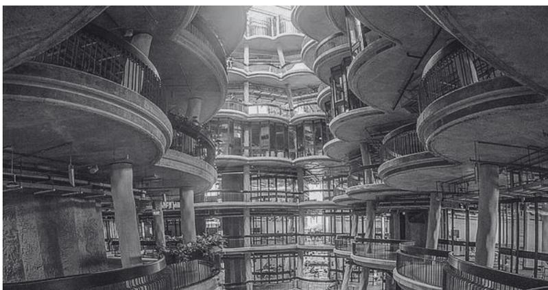
Bangunan Learning Hub NTU ini menggunakan material beton untuk struktur maupun eksterior dan interiornya. Pada bagian eksterior, beton-beton melengkung dicetak menggunakan cetakan silikon dengan motif horizontal yang unik untuk membuat suatu tekstur tiga dimensional. Pada bagian dalam, beton-beton dihiasi oleh gambar-gambar karya ilustrator Sara Fanelli yang dicetak secara tiga dimensional pada beton bagian tangga dan core elevator.
