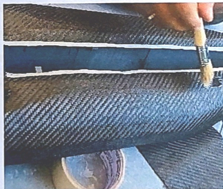
Gambar 3- 17 Proses pengolesan resin
