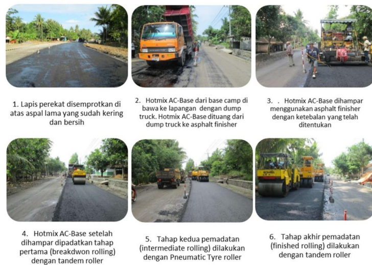
Gambar 5.2 Pekerjaan Laston Lapis Pondasi (AC-Base)
