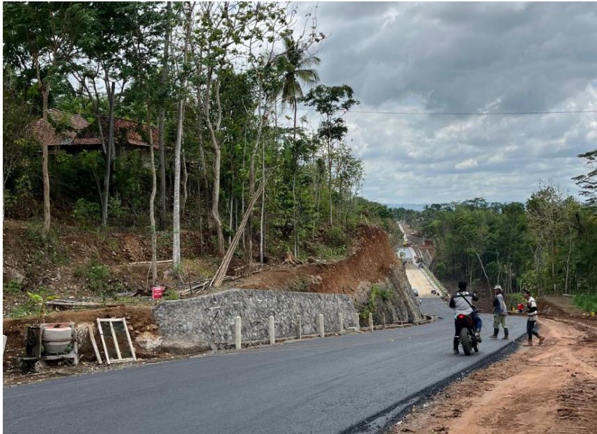
Gambar 5.1 Lokasi Proyek Pembangunan Ruas Jalan dan Jembatan Tawang Ngalang Segmen II
