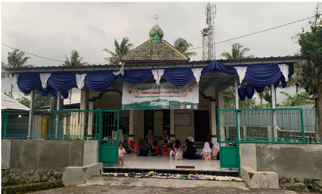
Kondisi Masjid Miftahul Jannah
