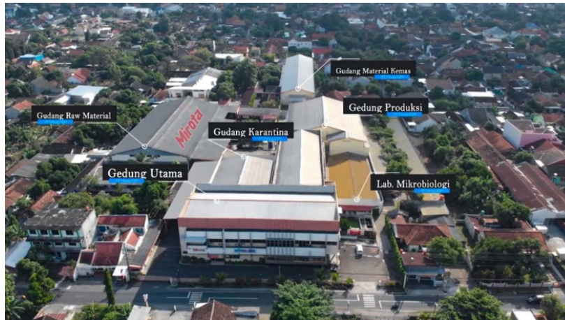
Gambar 1.1 Gedung PT. Mirota KSM Yogyakarta (Sumber: mirota.id)
