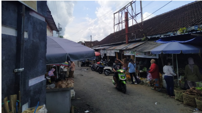
Gambar 1.4 Kondisi Sisi Utara Pasar Pakem Sumber: Penulis, 2022
