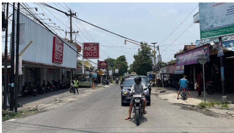
Gambar 5.8 Hambatan Samping Jalan Gadjah Mada (Selatan) pada Simpang 4 Cebongan
