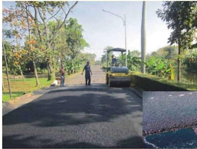
Gambar 3.40 Lapis Tipis Beton Aspal (LTBA)
