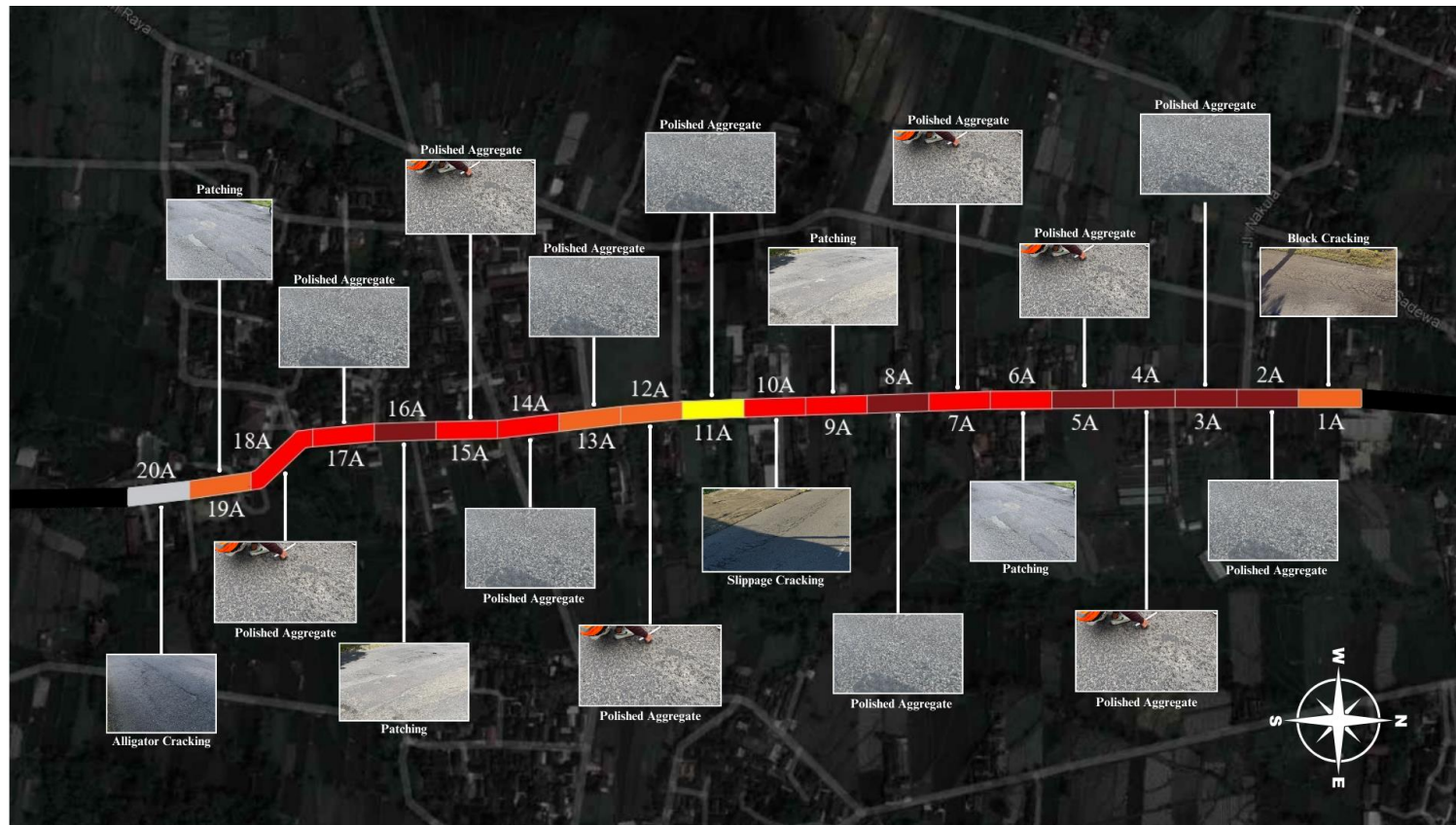
Gambar 5.15 Kondisi Jalan dan Kerusakan Dominan pada Tiap Unit Sampel
