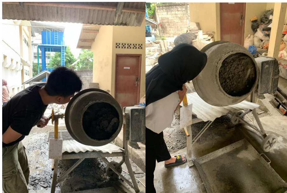
Gambar L-2. 16 Proses Pembuatan Campuran Beton
