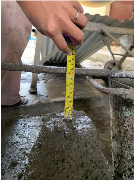
Gambar L-2. 17 Proses Pengujian Nilai Slump
