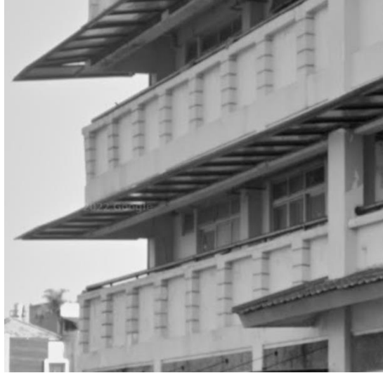
Gambar 20. Tampak Depan Rusun
