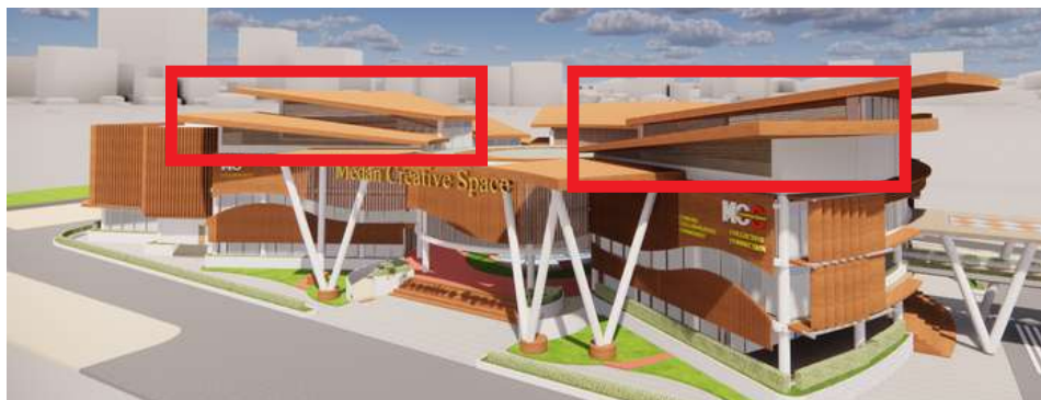
Gambar : Ventilasi pada area Atap Bangunan Sumber : Analisis Penulis (2022)
