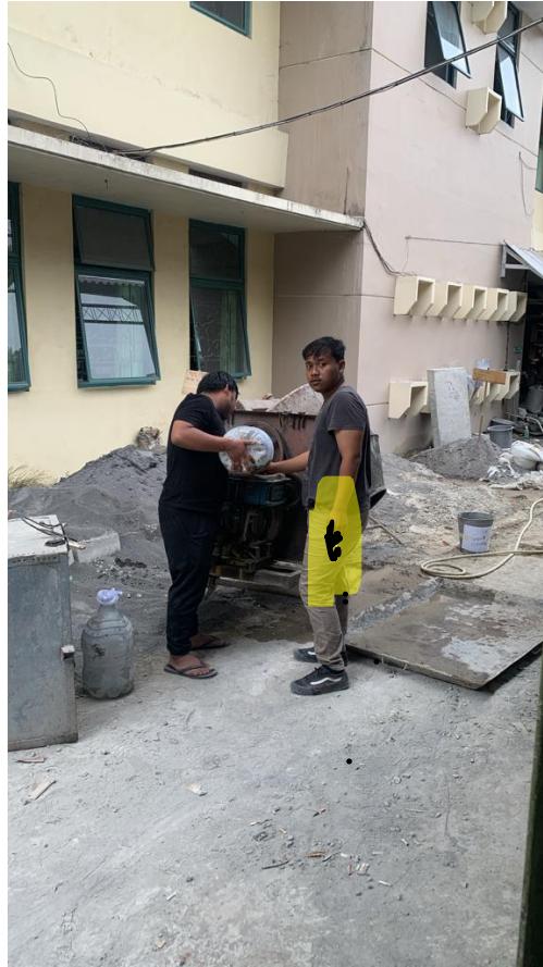
Gambar L-1. 10 Proses Persiapan Pencampuran Beton Geoplimer
