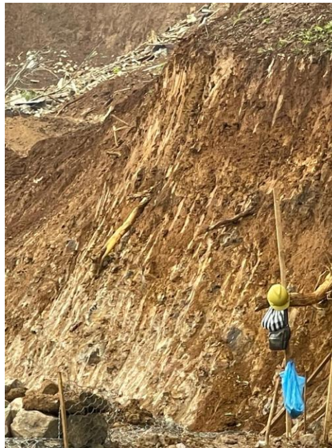
Gambar 1.1 Kondisi Lereng Setelah Longsor
