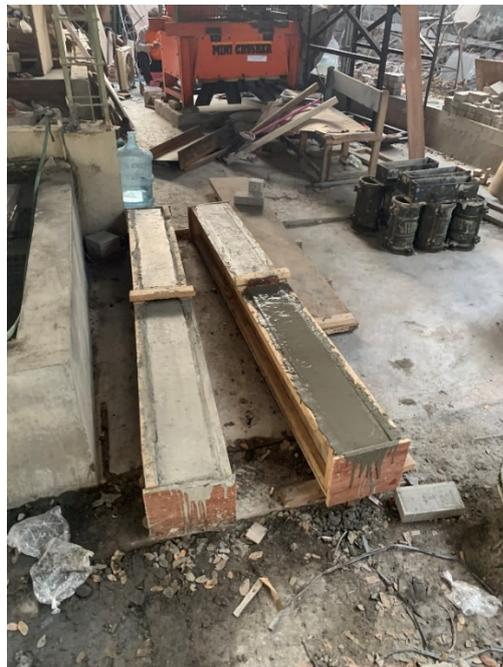
**Gambar L-7.2 Pengecoran Benda Uji**
