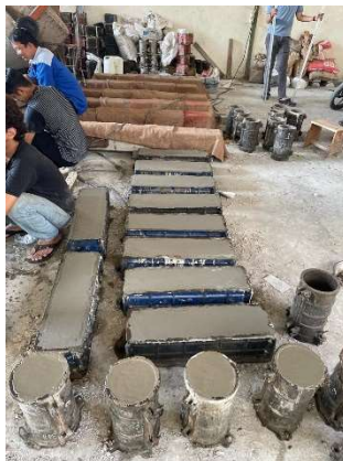
Gambar L-10. 3 Pencetakan Beton Segar
