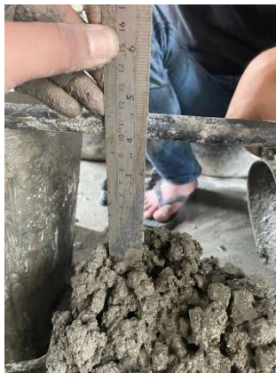
Gambar L-10. 2 Pengujian Nilai Slump Beton
