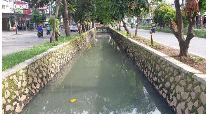
Kondisi Saluran SU01
