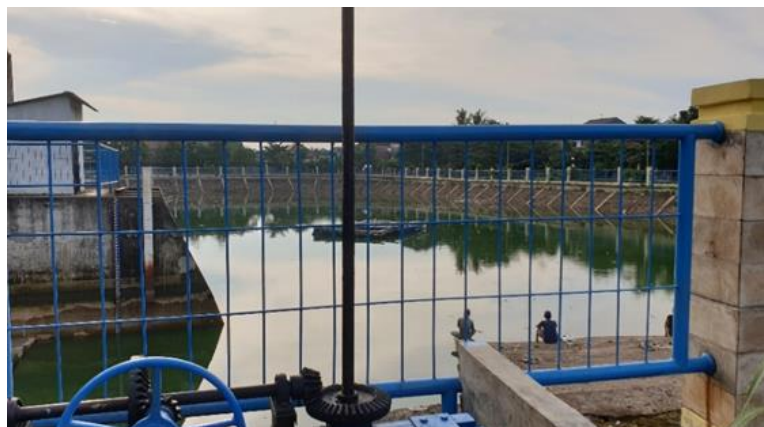
Kondisi Kolam Retensi
