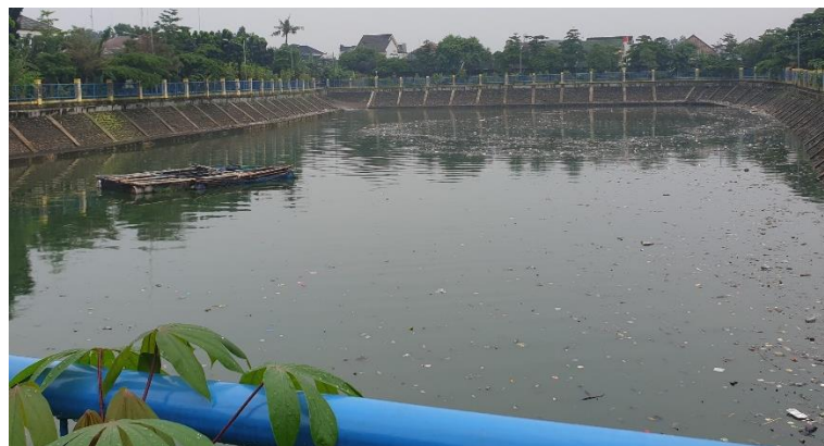
Kondisi Kolam Retensi existing
