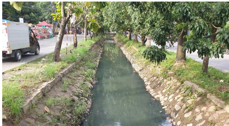
Kondisi Saluran SU02
