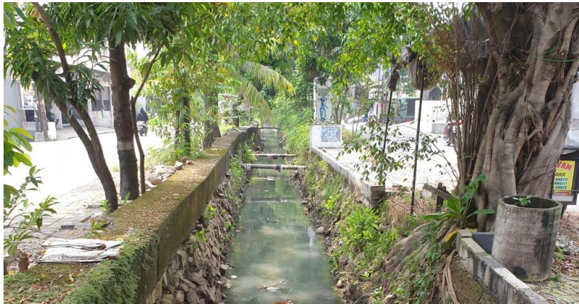
Kondisi Saluran SU05
