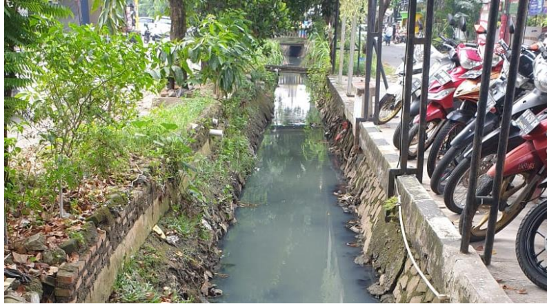
Kondisi Saluran SU04
