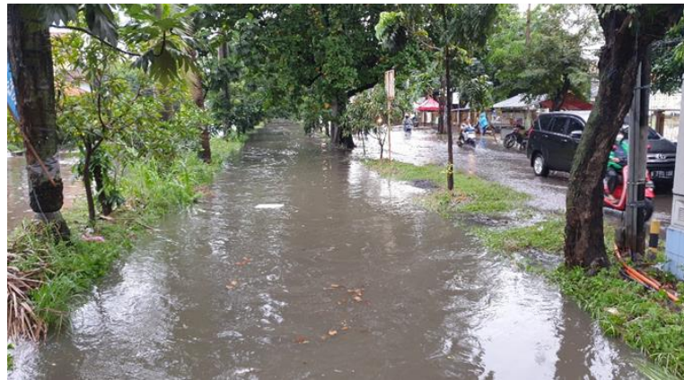
Kondisi Banjir Saluran SU02
