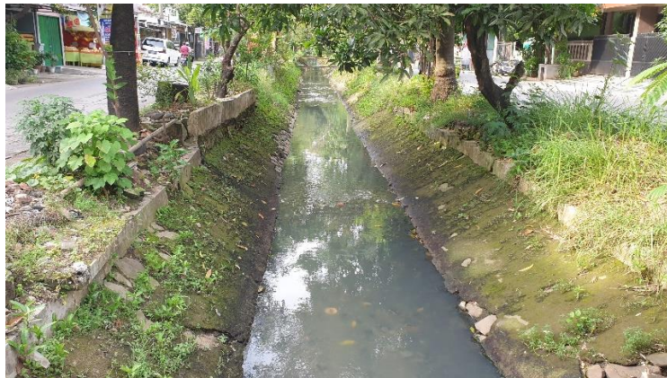
Kondisi Saluran SU03
