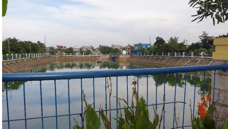
Kondisi Kolam Retensi
