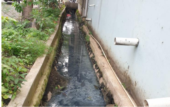
Kondisi Saluran SU06 Ka
