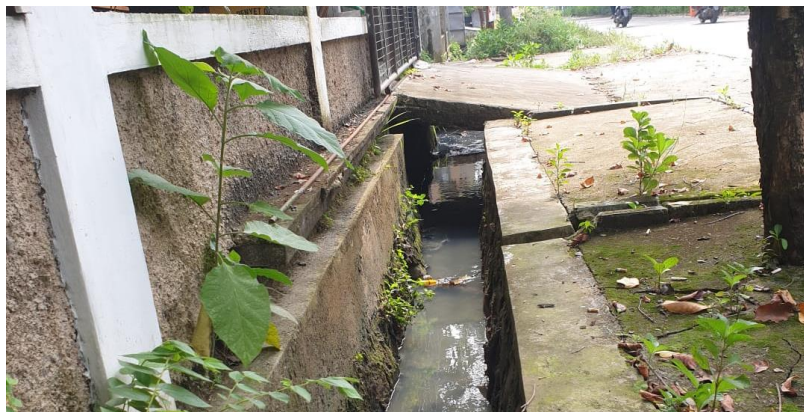
Kondisi Saluran SU06 ki
