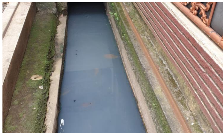
Kondisi Saluran SS01 ka
