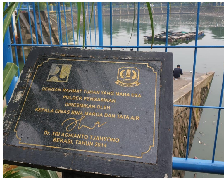
Kondisi Kolam Retensi
